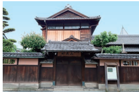
落ち着いた風格を感じさせる東門。門戸にはケヤキの一枚板が使われている。
