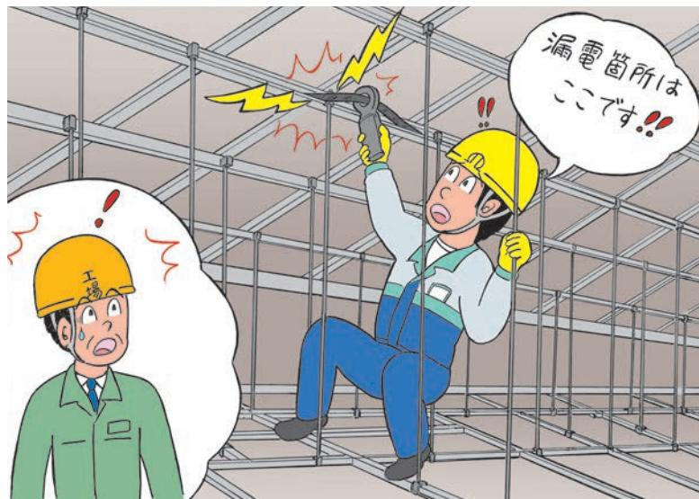
旨をお伝えしました。屋根を二重に修繕された箇所の配線を確認するため、時には狭い空間をほふく前進しながら漏れ電流測定をしました。すると、やはり、屋根の工事で取り付けた金具が配管を突き抜け、中の電線を傷つけたことが原因で、その金具から鉄骨に漏電
