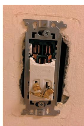
コンセントの上部が破損し、下部の差し込み口に金属片が刺さった状態
