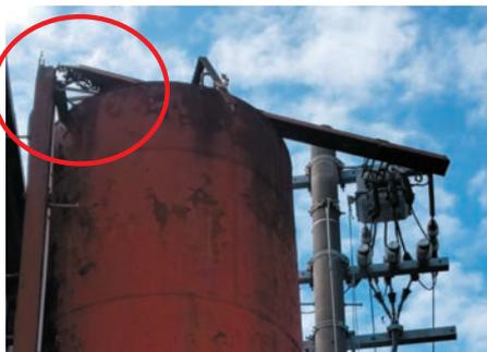
構内柱に向かって折れて倒れた鉄柱
