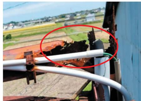
錆により腐食している鉄柱
