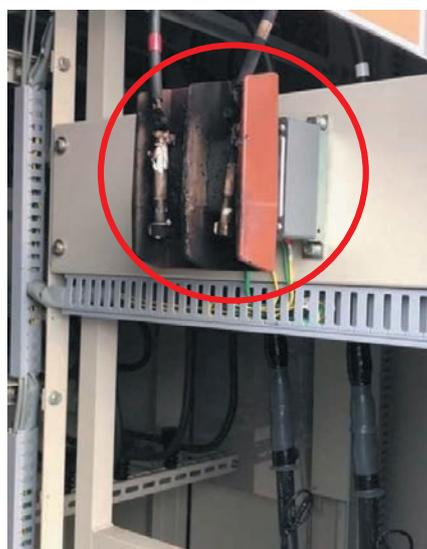
災害後（VT短絡により損傷）
