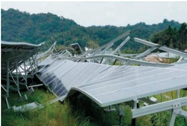
近年、強風の際に太陽電池発電設備のパネルが飛散、架台が倒壊するなどの事故が発生しています。なかには飛んだパネルが近隣の住宅へ被害を与えた例も。万が一、他者に被害が及んだ場合には、刑事責任や民事責任が生じる可能性があります。
